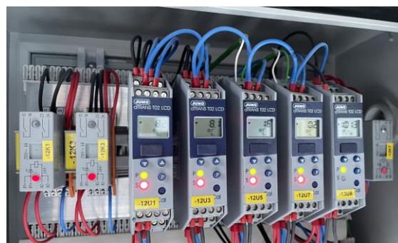
Temperaturmessumformer
